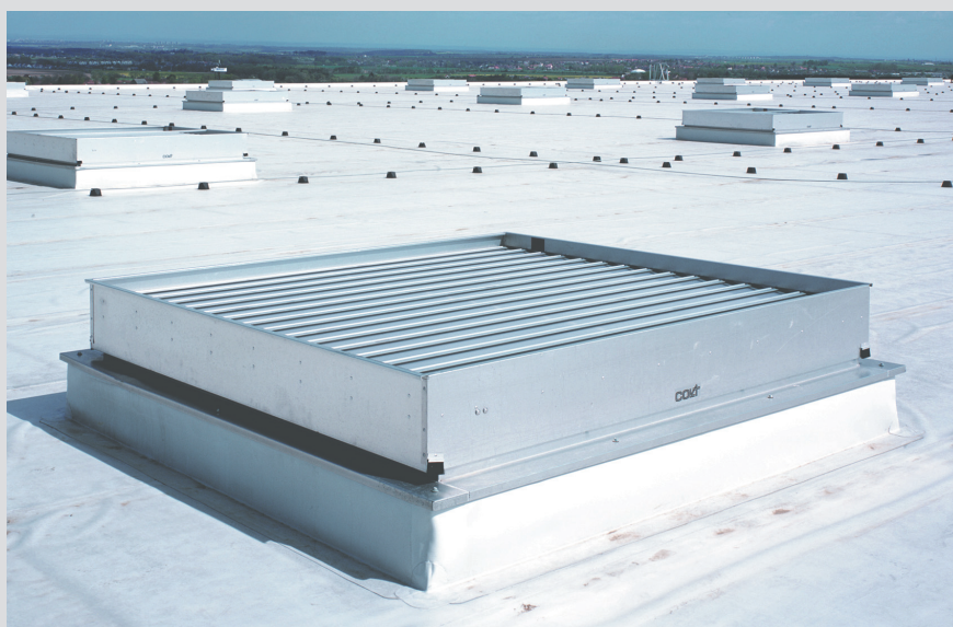
▲ Естественная вентиляция и дымоотведение
